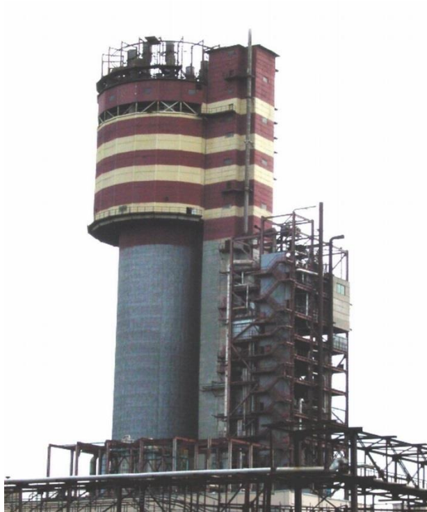
Рисунок 8.13 — Башня прилливания с железобетонным стволом
