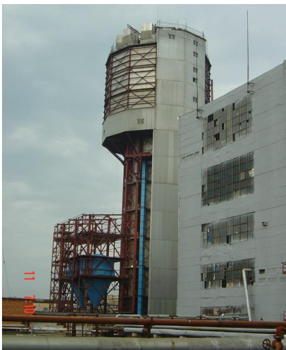
Рисунок 8.14 — Башня прилливания с металлическим стволом
